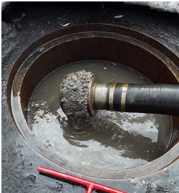
Lingettes en suspension obstruant une crépine
